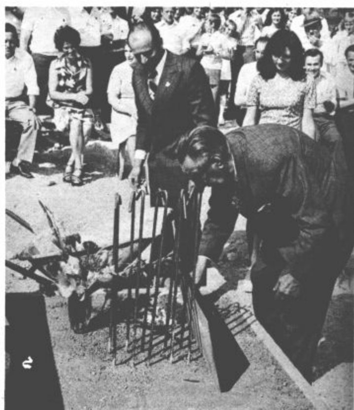
S tremi „kelami“ betona je Franc Leskošek—Luka zazidal temeljno ploščo za nov dom družbenih organizacij v Gaberkah.
