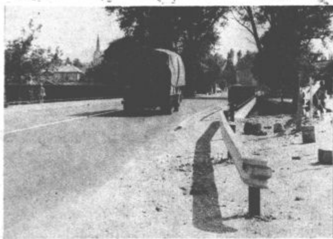
Kar nekam neopazno (pa v veliko veselje voznikov motornih vozil) so delavci Splošne vodne skupnosti NIVO Celje dogradili nov most čez Mislinjo pri Tovarni meril Slovenj Gradec in ga predali svojemu namenu. Odpravljeno je še eno tesno grlo na regionalni cesti Dravograd-Velenje-Arja vas.
