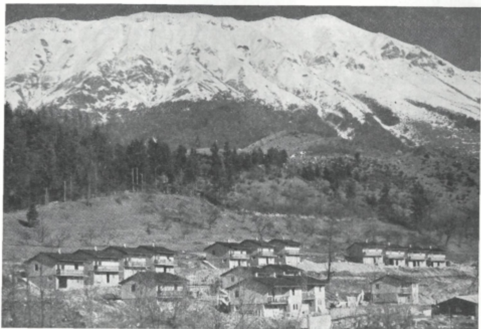
Sl. 26. Novi Breginj v gradnji
