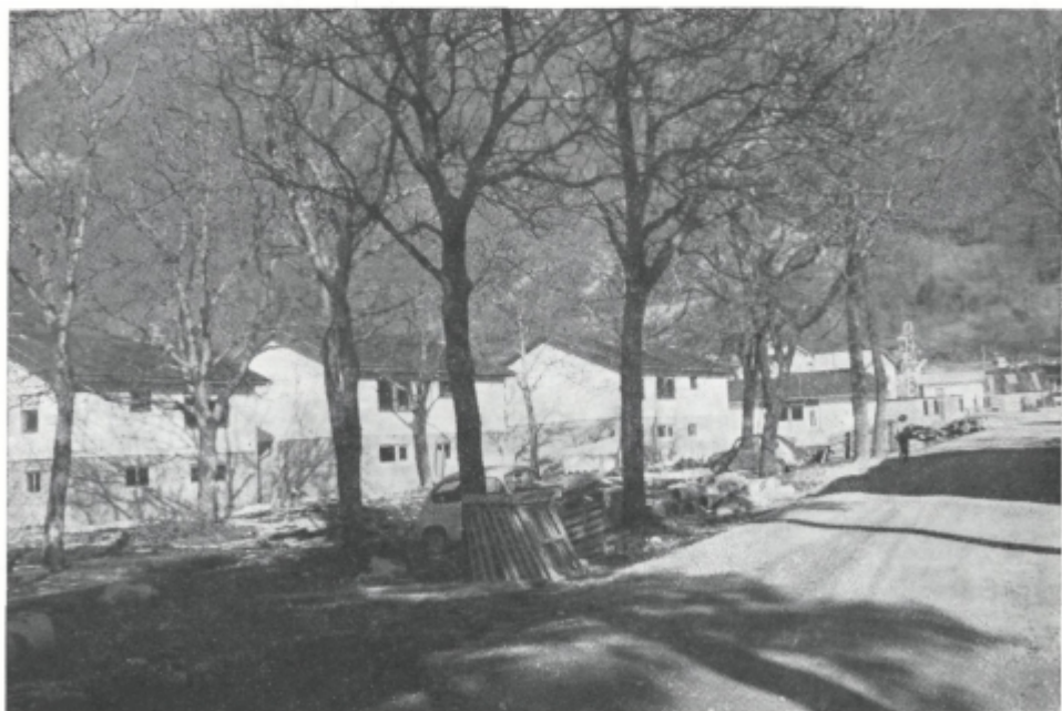
Sl. 28. Montažne hiše v Smastu. Večina novih hiš, ki so jih zgradili v Posočju, ima zidano prtiličje, kar je zelo pomembno, saj so morali zaradi posledic potresa podreti tudi zelo veliko pomožnih objektov
