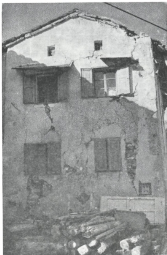
Sl. 6. Močno poškodovana hiša v Breginju, na fasadi so vidne številne razpoke. Celotna konstrukcija hiše je zelo poškodovana in je bila stavba uvrščena v 3. kategorijo poškodovanosti
