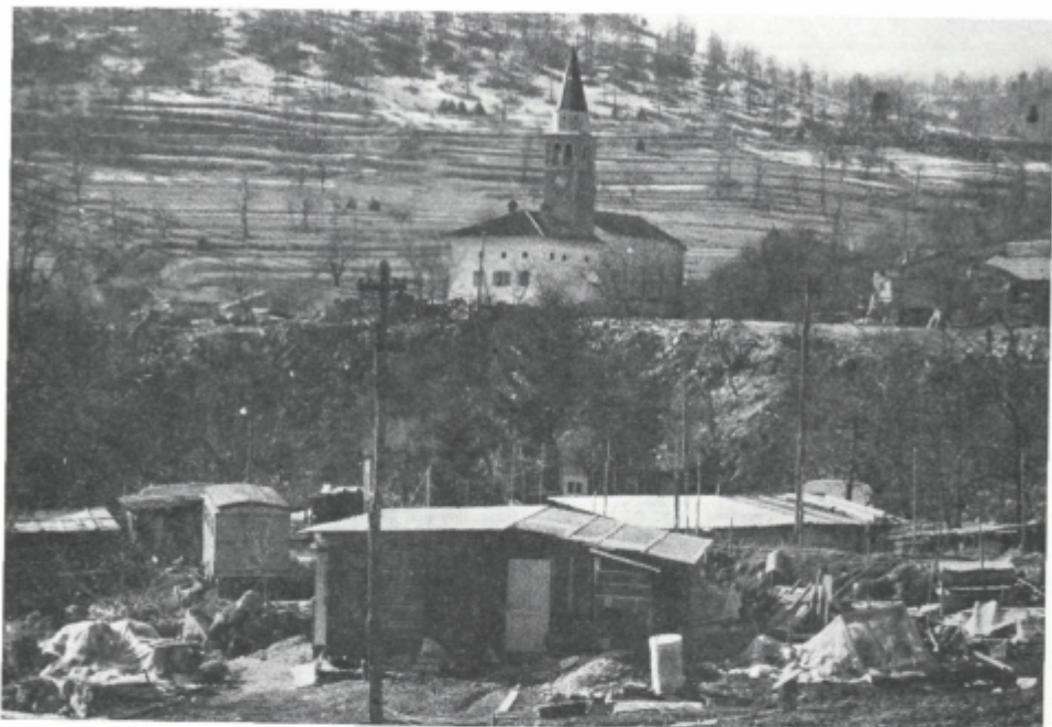
Sl. 25. Starega Breginja ni več. Močno poškodovane hiše so podrli in ruševine odstranili. Pod vasjo in nad njo so nastala začasna bivališča
