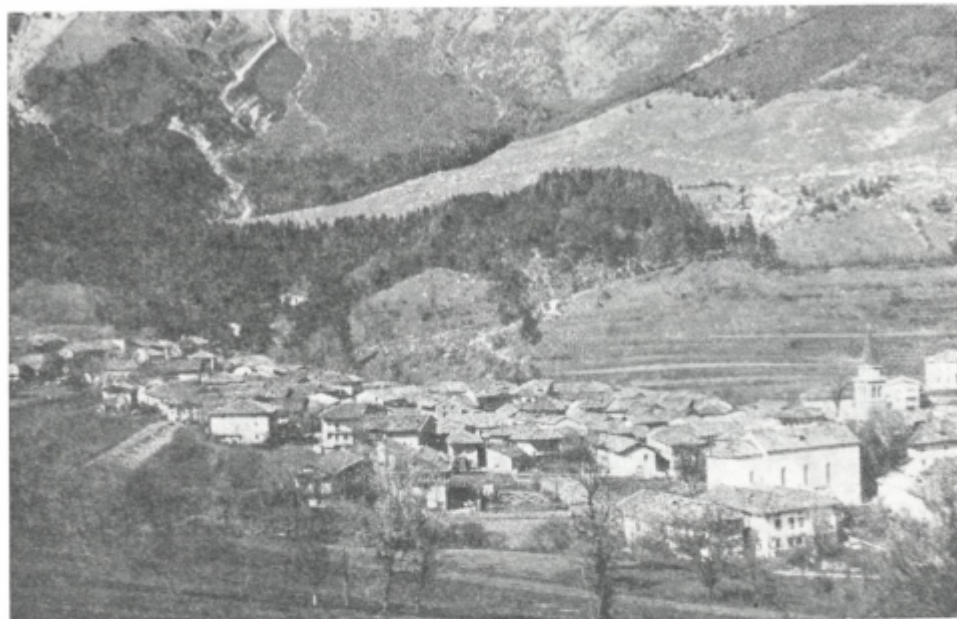
Sl. 23. Pogled na Breginj (posneto leta 1966). Razen redkih izjem ob naselju ni bilo novejših stavb. Lepo je vidna zaokrožena urbanistična celota s tesno skupaj postavljenimi hišami, zgrajenimi v značilni arhitekturi (Foto prof. S. Peterlin, Zavod za spomeniško varstvo SRS)
