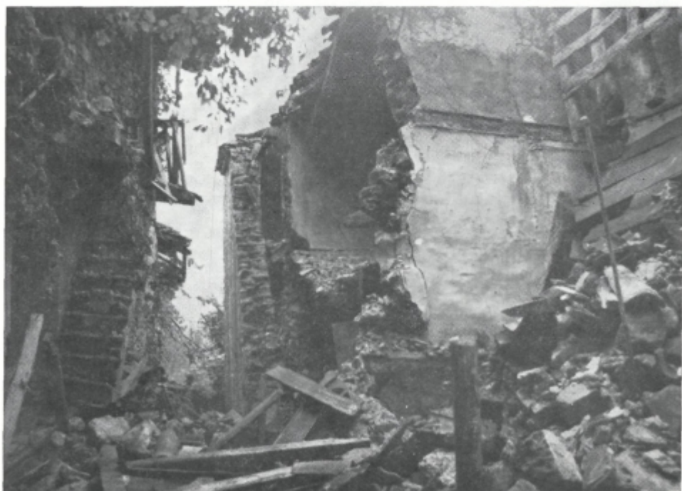
Sl. 21. Ob številnih novih potresih so bile mnoge hiše dodatno tako poškodovane, da so se povsem porušile. Prizor je bil posnet v Podbeli v času tik pred odstranjevanjem ruševin
