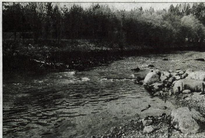
Nevarne traverze, ki štrlijo iz Save Dolinke pri Šobcu...
