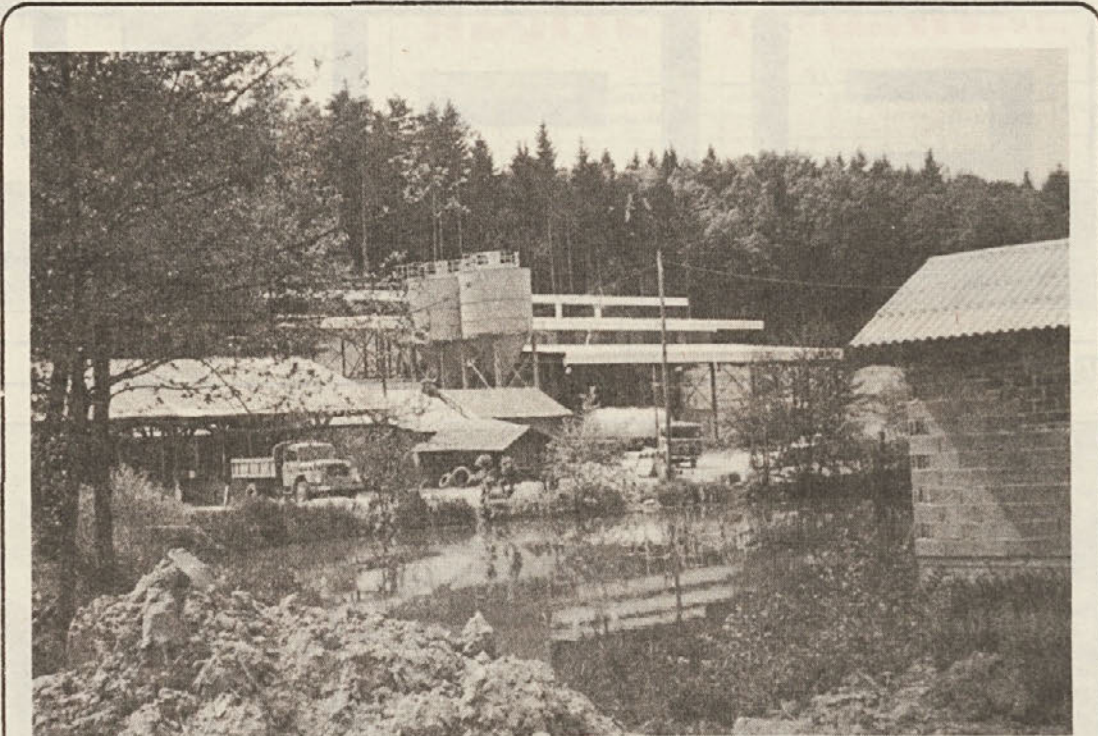
Objekt za proizvodnjo ognjeodpornih materialov in suhega peska na Mokrem polju. Objekt je še v poizkusni fazi. Pesek se bo uporabljal v livarske, steklarske in gradbene namene. Gradbena dela je opravil Pionir (foto: Borsan).
