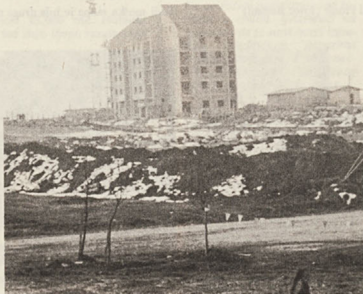
Dela na tem objektu tečejo po planu. Trenutno izvajajo grobo instalacijo, grobi in fini omet. V aprilu bo postavljen fasadni oder, objekt pa bo v celoti končan v pogodbenem roku, to je avgusta 1983. (Foto: BORSAN)
