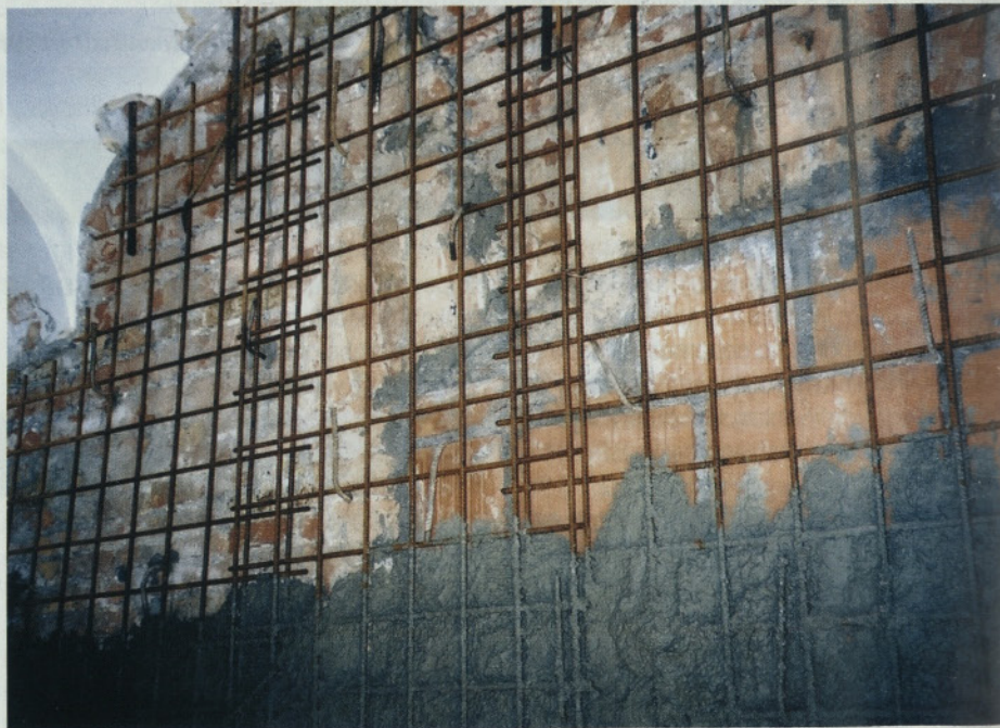
Slika 4 • Izvedba obojestranskih armiranih ometov opečnih zidov
