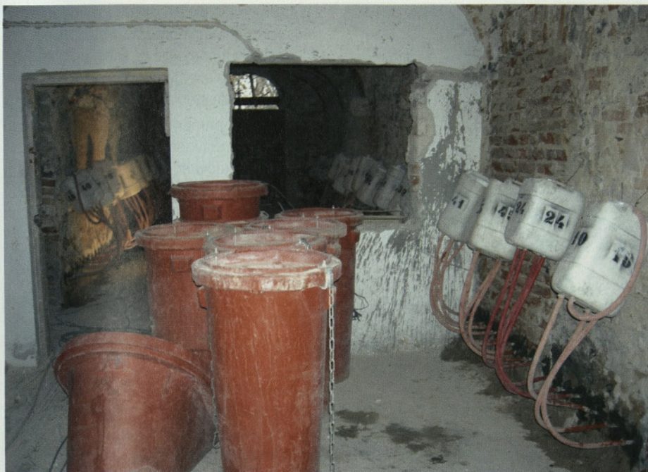
Slika 10 • Izvedba hidrofobne bariere z raztopino silikonov
