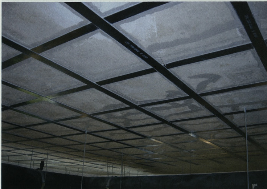
Slika 9 • Povečanje nosilnosti armiranobetonske plošče s karbonskimi lamelami
