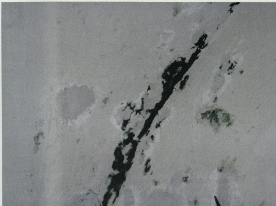
Slika 13 • Nastanek plesni na stiku z armiranim ometom utrjenega zidu in oboka, do katere je prišlo zaradi neupoštevanja spremembe gradbeno fizikalnih razmer
