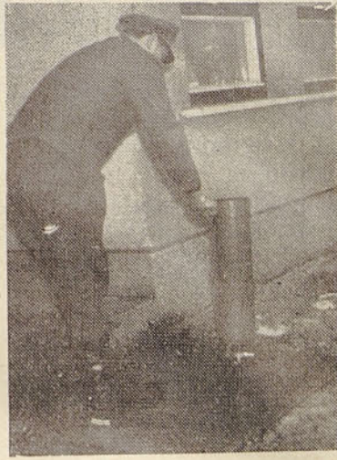
Ga obrnemo narobe, udarimo z udarno iglo ob trd predmet
