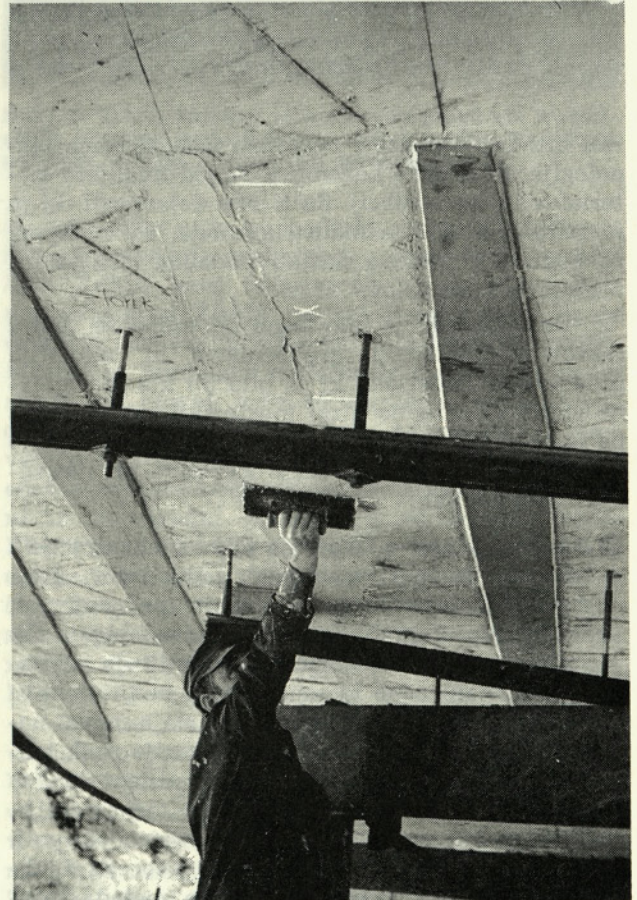
Slika 1. Sanacija armiranobetonske konstrukcije z dopljenjem armature
