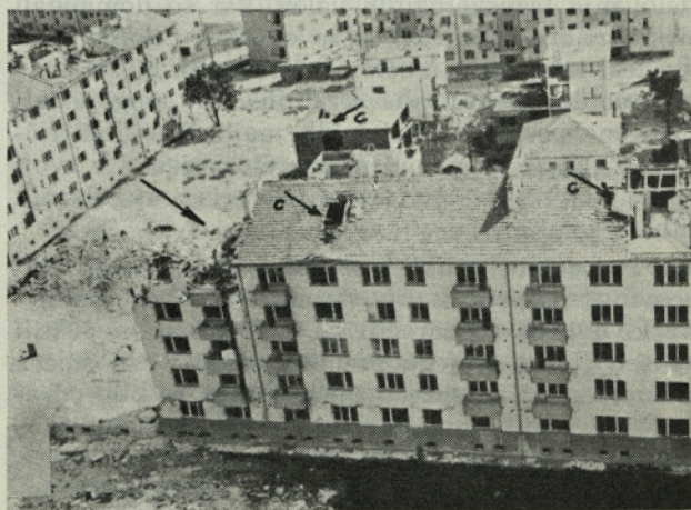
Sl. 7. Mestna četrt Karpoš. Najvzhodnejši del opečnih stanovanjskih blokov je bil porušen. Dimniki (c) so padli na vzhodno stran
