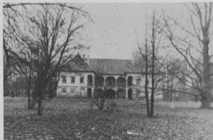
Razpadajoča zgradba Poklicne poljedelsko živinorejske šole Turnišče.
