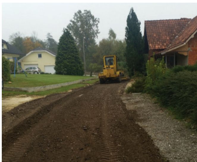
Začetna dela na cesti v Vitomarški vasi
