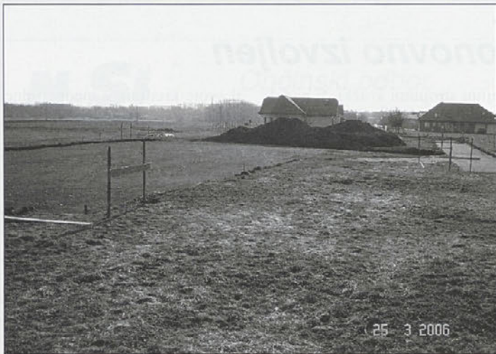
Podoba gradbišča pred pričetkom asfaltiranja.
