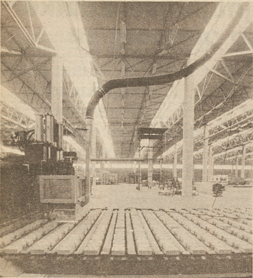
Nova IMV-jeva proizvodna hala, v kateri delajo monterji tozda Elektromontaža.
