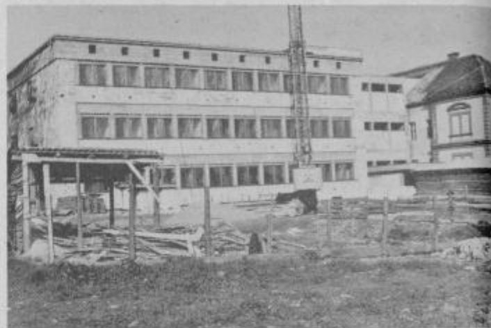
Novi prizidek ptujske bolnišnice čaka na dograditev ...
