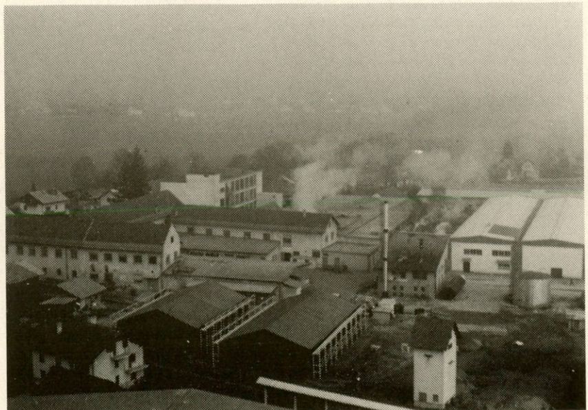
panoramski posnetek s silosa – februar 1989
