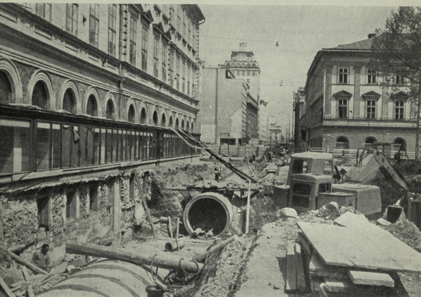
MESTNA KANALIZACIJA V LJUBLJANI — GRADNJA INSTALACIJSKEGA KOLEKTORJA NA TITOVCI CESTI
