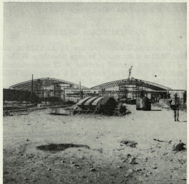
Sl. 9. Pogled na dvoje dovršenih boksov skladišča
