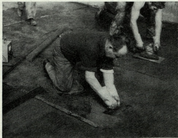
Sl. 2. Polaganje epoksidne prevleke
