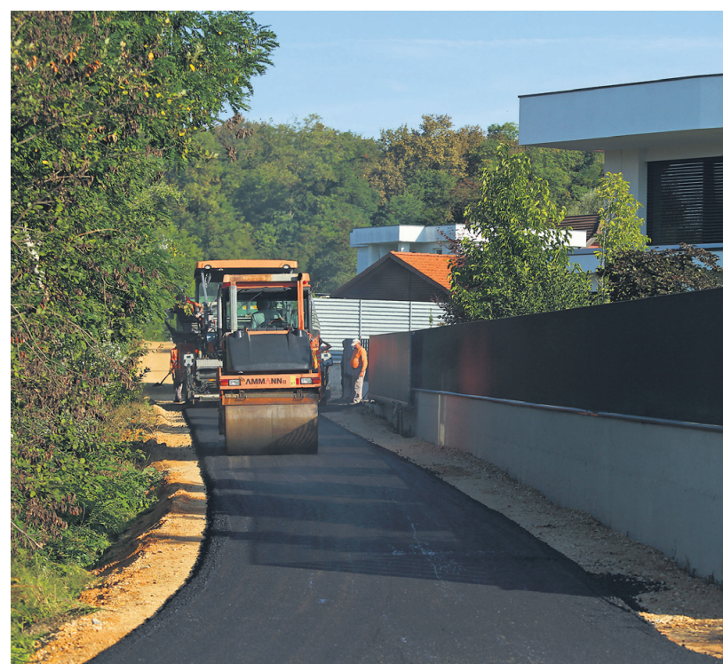
Cesto, ki vodi do deponije, so končno začeli asfaltirati.
