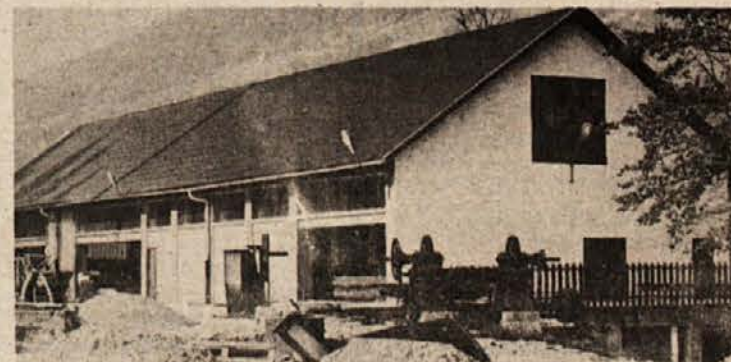
O POŽGANEM NI VEČ SLEDU — Novolesovo žago v Sotški, ki jo je povsem uničil požar, so že obnovili. Zdaj nameščajo opremo in opravljajo zadnja dela, da bo lahko žaga spet začela obratovati. Predvideno je, da bo otvoritev že v letošnjem letu. (Foto: Bačer)
