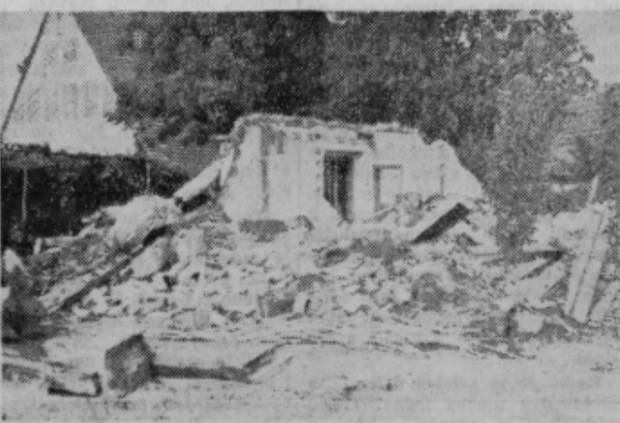
Podrta stanovanjska hiša družine Zupanič ob Mlinski cesti v Ptuj. Voda je dosegla okno in zmečkala but, ki se je sedel v vodo in za seboj potegnil tudi osterže. Takoj po prestanku poplave so pripadniki JLA pospravili material razdrite hiše na svoje mesto
