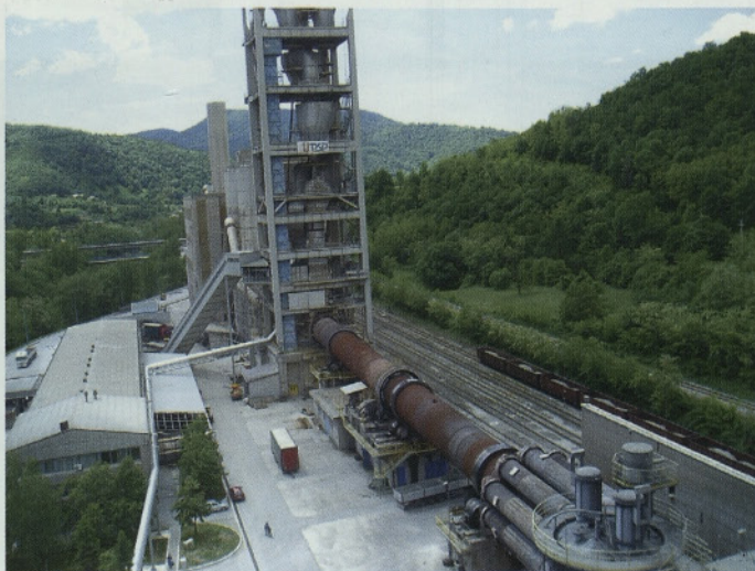
Slika 7 • Stolp izmenjevalnika toplote, rotacijska peč in novi cevovod
