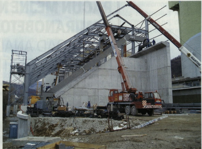
Slika 19 • Montaža polportalne konstrukcije odvzemnika
