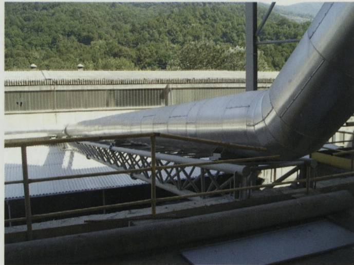
Slika 10 • Cevovod preko trikotnega paličnega mostu
