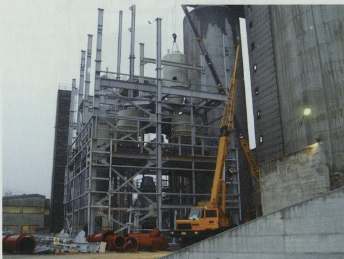
Slika 13 • Montaža konstrukcije in silosa
