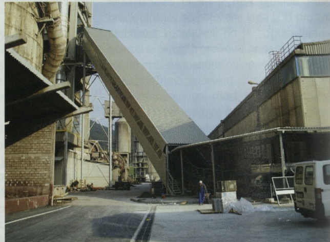
Slika 5 • Transportni most z delom nadstrešnice
