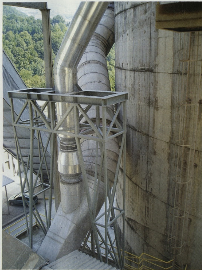
Slika 9 • Detalj priključka kraka cevovoda na obstoječi cevovod
