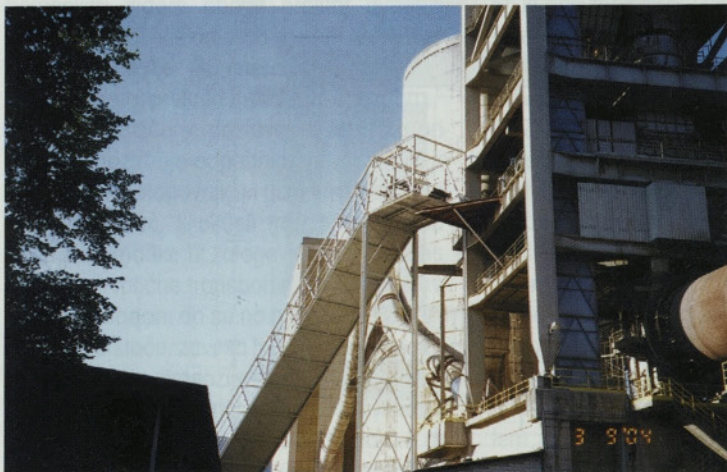
Slika 4 • Transportni most po montaži
