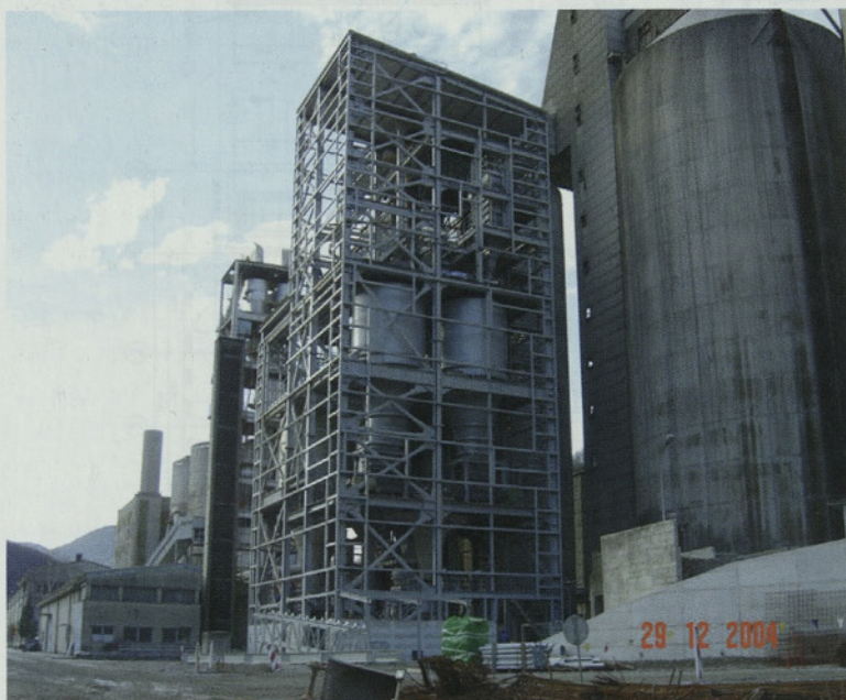
Slika 15 • Zmontirana jeklena konstrukcija
