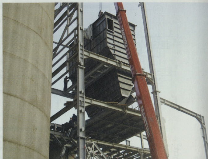
Slika 14 • Montaža filtra
