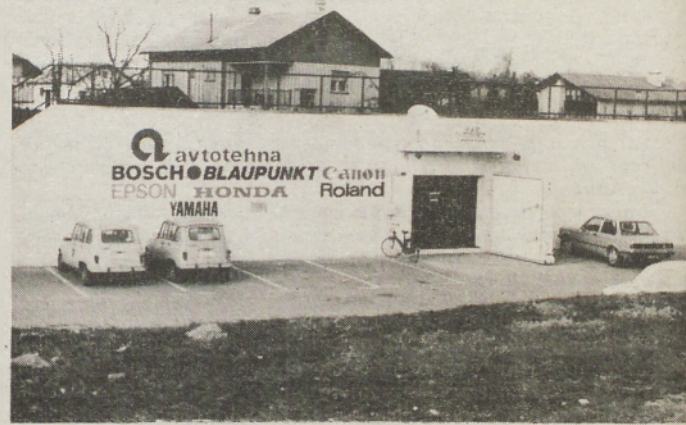
Najnovjša smotrna izraba zaklonišča je na Lendavski ulici v Murski Soboti, kjer je tehnična trgovina. Če bo treba, mora biti v 12 urah izpraznjena!
