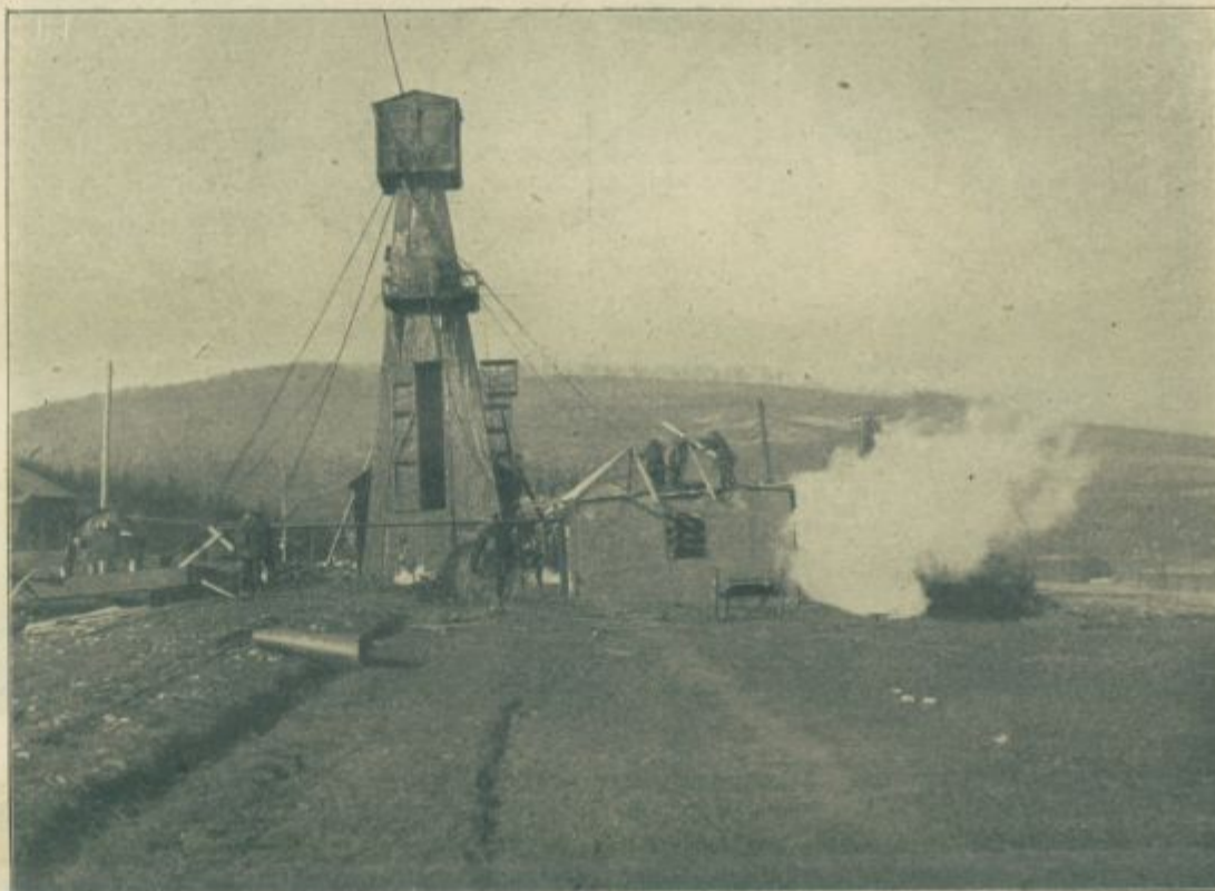
Stolp za iskanje naftinih vrelcev. V stolpu je vrtalo, ki se s pomočjo raznih naprav zavrti globoko v zemljo, kjer se sluti, da se nahaja nafta. Naftini vrelci se redkokdaj zasledé in so važni za produkcijo surovega petroleja. — Slika nam kaže tak dogodek iz Borislava, kjer so po devetih letih zopet zasledili nafto.
