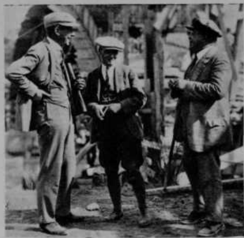
Graditelji novega mostu na cesti Lesce-Bled. Od leve na desno: podjetnik Sla- vec, prof. dr. Kasala, ki je napravil načrt, inž. Juvan, nadzornik gradnje.
