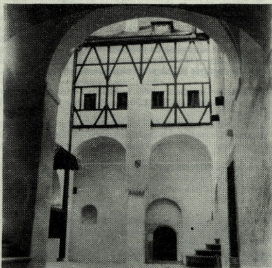
Del obnovljenega dvorišča na gradu Podsreda
