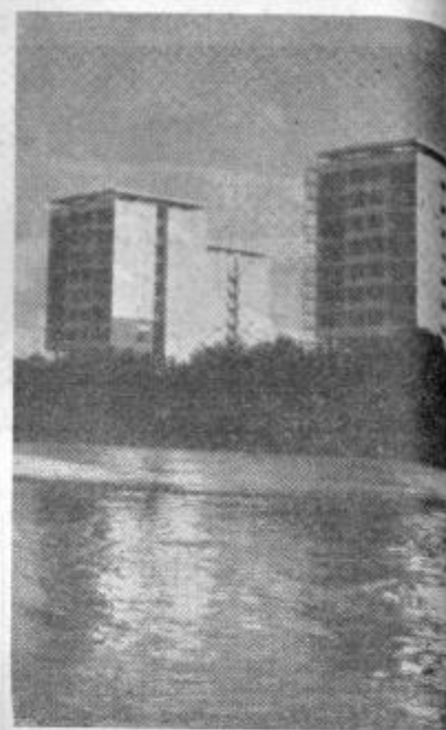
Pogled na stolpnice ob Vardarju, k so se sesule ob potresu kot hiše iz kart in pokopale pod seboj še speči stanovalec.
