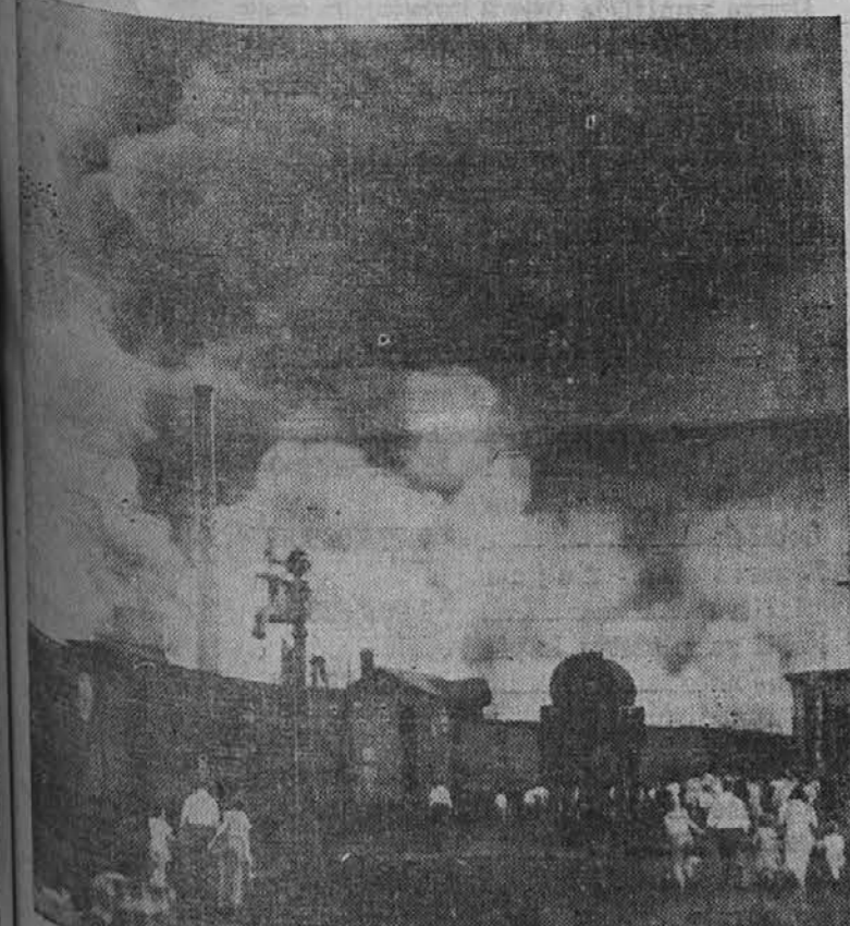
Na železniških "jardih" Boston & Maine železnice v Charlesu, Mass., je nastal velik požar, ki je povzročil $750,000 škode.
