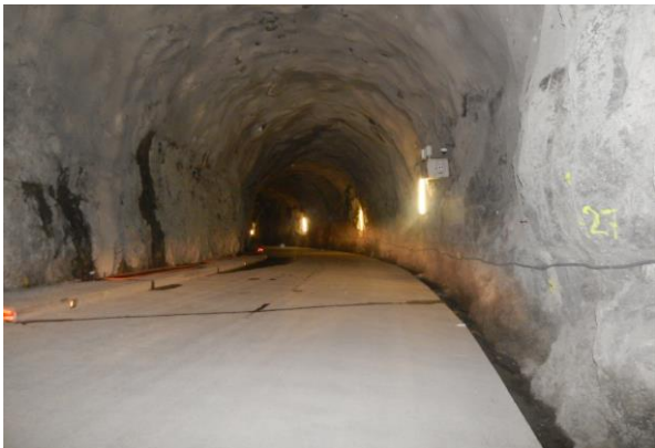
Slika 7: V podzemlju pregrad Emosson.
