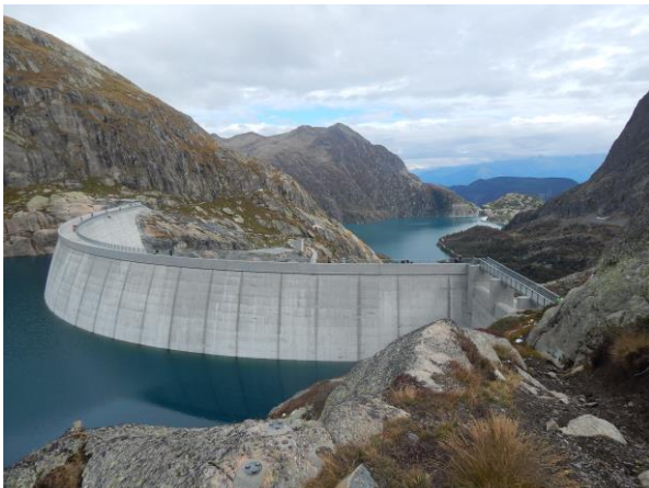
Slika 8: Pogled na pregrado Vieux Emosson in nižje ležečo pregrado Emosson.
