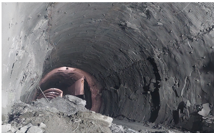
Slika 9. Izmerjene deformacije so bile velikostnega razreda tudi več kot 1 m.
