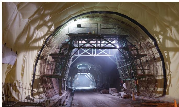
Slika 3. Hidroizolacija predora in izvedba armature notranje obloge.
