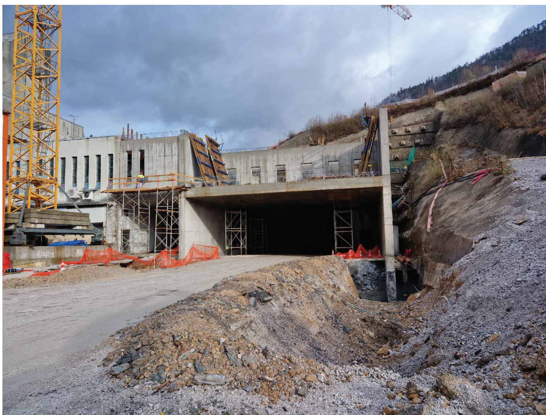
Slika 11. Portalna stavba v izgradnji, sledi izvedba galerije.
