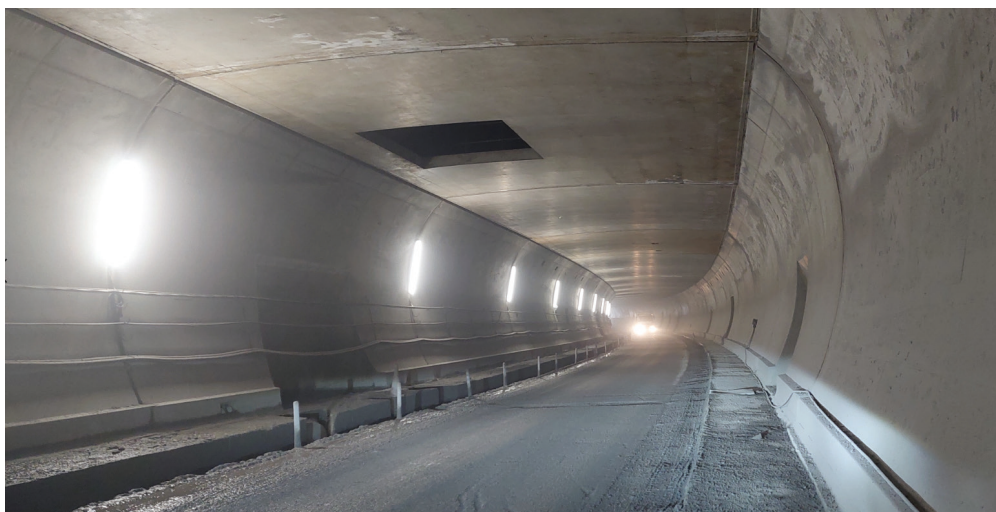
Slika 6. Izvedena notranja obloga in vmesna stropna plošča.
