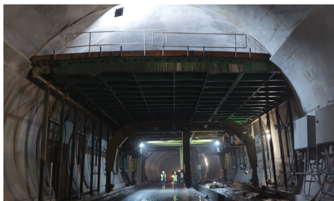
Slika 5. Opaž vmesne plošče.
