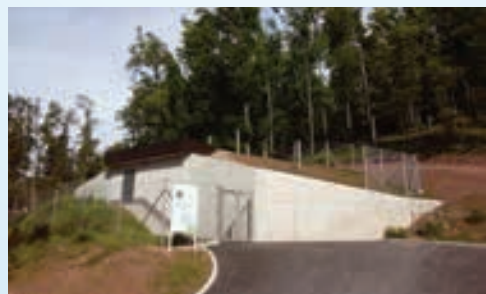
Izgrajen vodohran Lukovica
