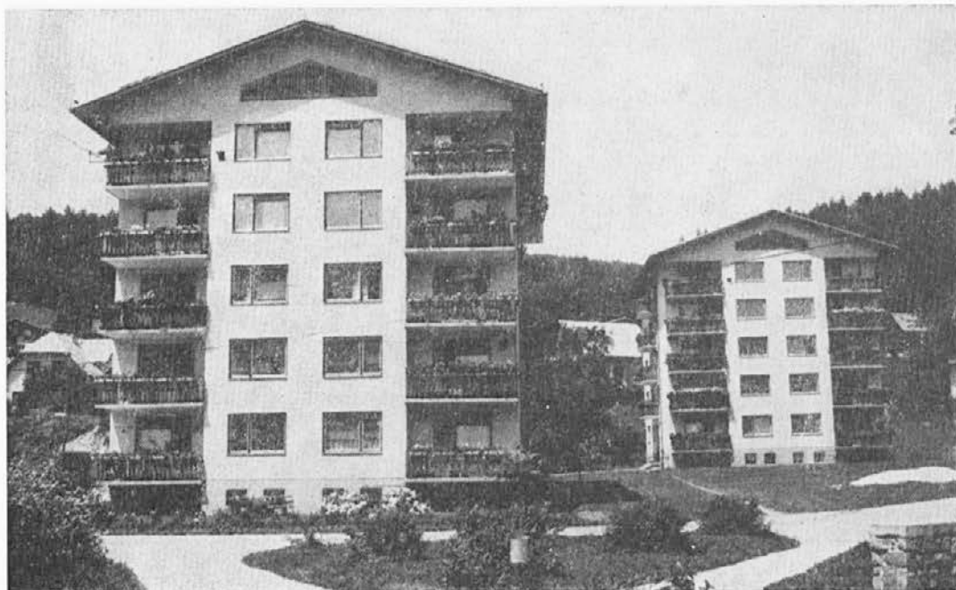
Blok DU na Prevaljah
