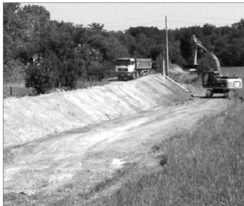
Bager med gradnjo nasipa v Dolnjih Gabrjah
