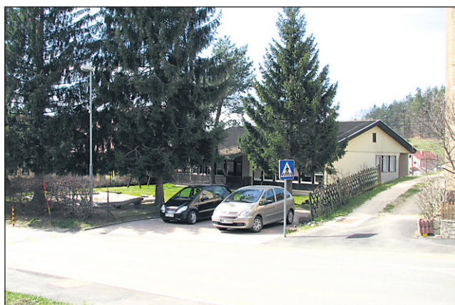
Foto: SM Na lokaciji starega vrtca, ki ga bodo podrli (na posnetku), naj bi se že letos začel graditi poslovno-stanovanjski objekt; investitor je podjetje GP Project ing., d. o. o., stavbno pravico pa mu je za dobo 99 let podelila občina Cirkulane.
