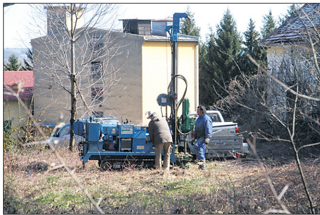
Na območju nekdanjega Kmetijskega kombinata so ta teden opravili poskusne vrtine za gradnjo novega doma starejših občanov.
