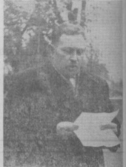
Pred grobom padlih borcev je govoril Stane Smajdl, predsednik krajevne organizacije ZB NOV Soštanj
