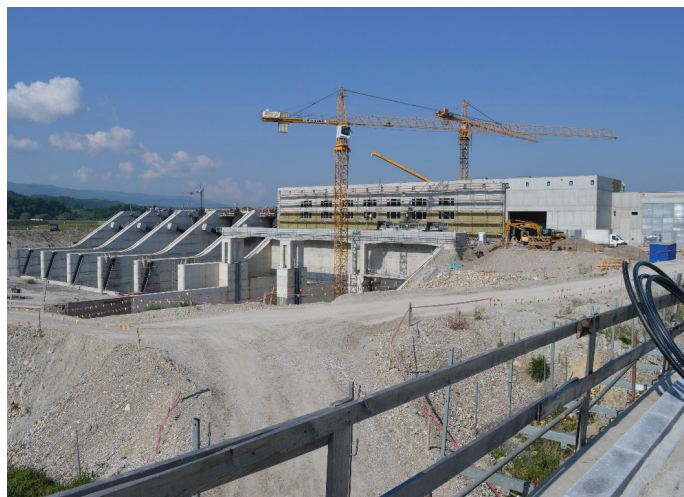
Slika 6. Meritve v času gradnje.
