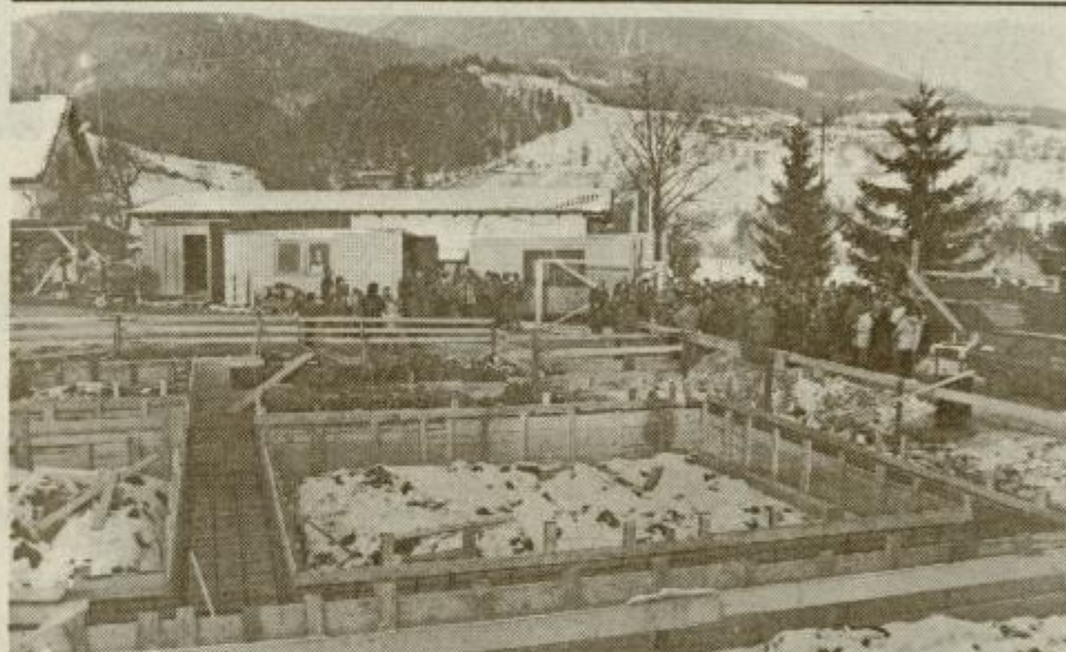
Gradbišče nove osnovne šole v Socki – temelji že stojijo.
