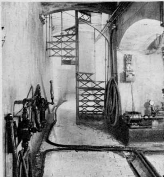
Zajetje podzemeljskih slatinskih vrelecev. Puisement des sources minérales souterraines. Erfassung der unterird. Rohitscher Quellen.
