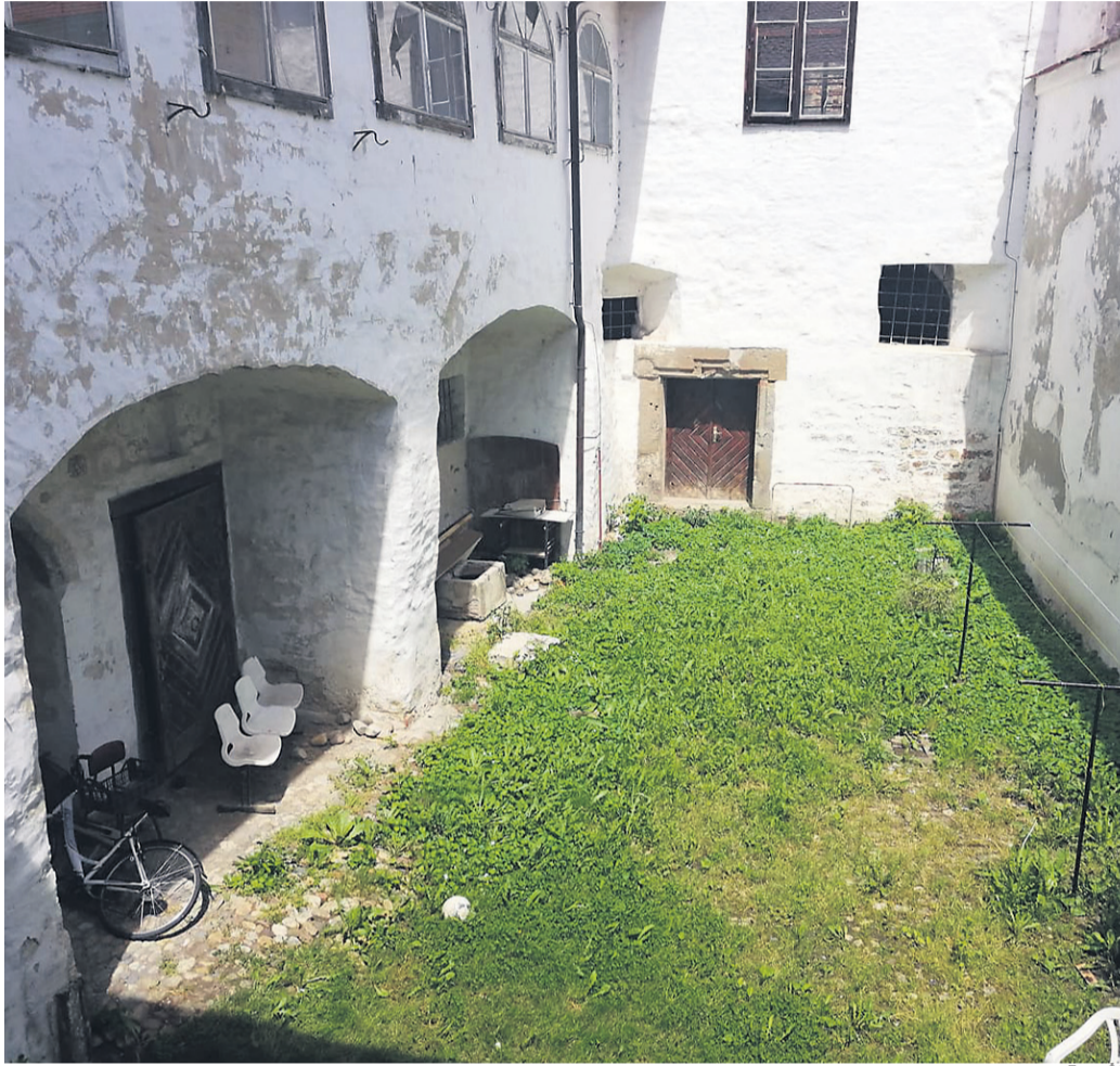
Stavba v Prešernovi ulici 4 je v celoti občinska, gre za najstarejšo meščansko zgradbo z lepim dvoriščem.
