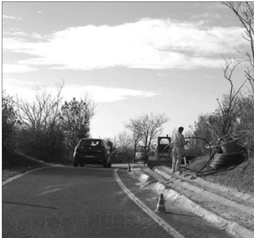
Polaganje optičnega kabla na cesti med Ronkami in Doberdobom BONAVENTURA
