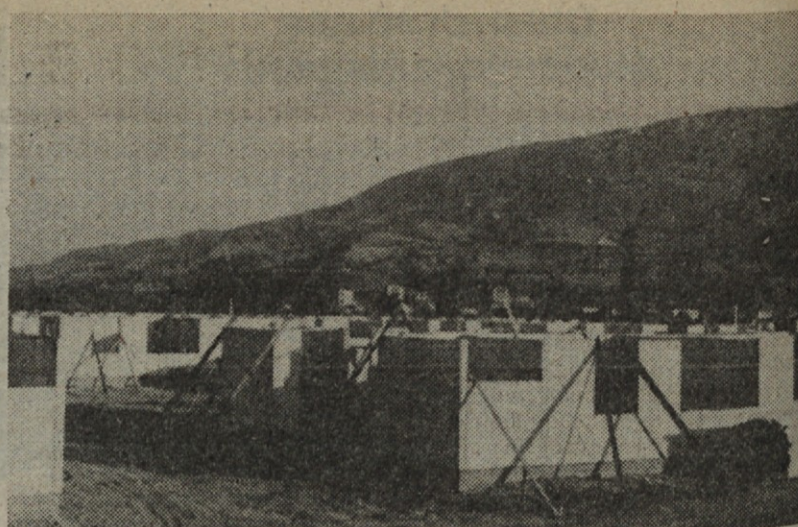
Prvi zametki naselja Vlaje, ki so ga postavili Gradisovi delavci
