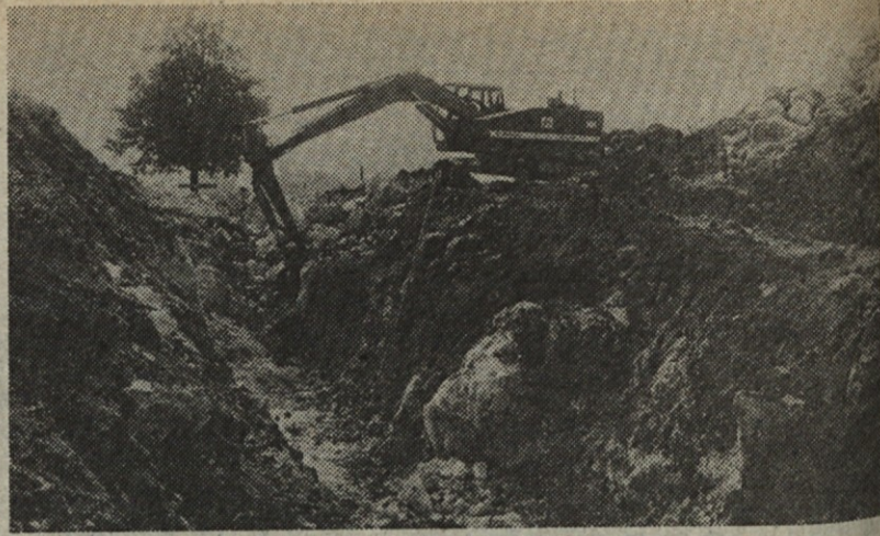
Zaradi težavnosti terena 5. kategorije so vsi izkopi za kanalizacijo dokaj zahtevni
