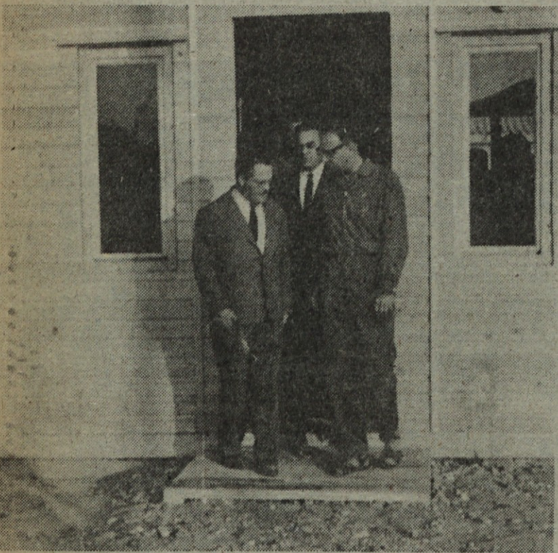
Tov. Edvard Kardelj na obisku pri Gradisu v Skopju na gradbišču Vlaj
