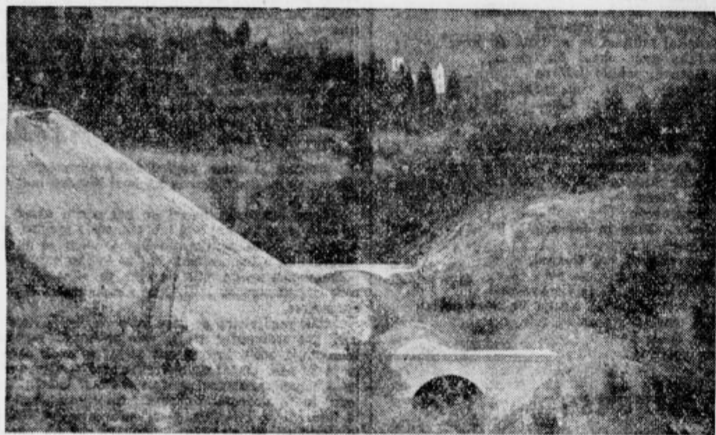
Na odseku Krkovo-Fara bo šla nova cesta po stranski dolini mimo vasi Fara. Šla bo po zanimivem svetu in tudi čez globoko grapo v visokem nasipu. Na levi vrh visokega nasipa, v sredi 38 m dolgi propust, pod katerim gre tudi poljska pot. Nad propustom bo nasip visok nad 10 metrov.
