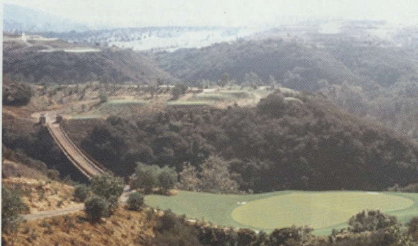
Slika 5: Most za pešce na igrišču za golf, Santa Fe ZDA.
