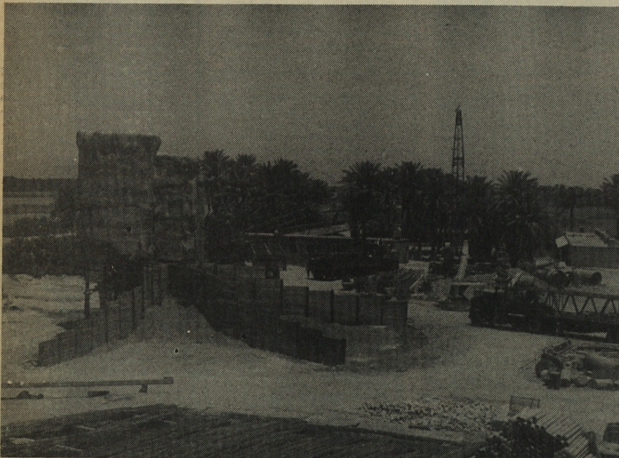
V Iraku zaščitijo silose za beton s posebnimi rogoznicami, da velika vročina in sonce nebi vplivala na kvaliteto betona
