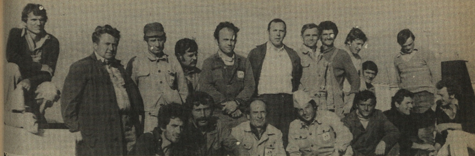
Koprski gradisovci v luki Bar. Daleč od doma, na zahtevnih objektih, ob poletni vročini, mrazu pozimi... in še enim prispevkom pri izgradnji jugoslovanskih luk in uveljavljanju Gradisa
