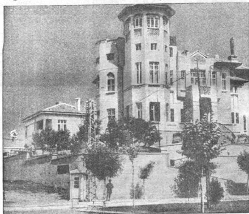
TURSKA PRESTOLNICA SE MODERNIZIRA. Moderna hiša v Ankari, ki združuje značilnosti Orienta in stavbarske odlike modernega sloga.
