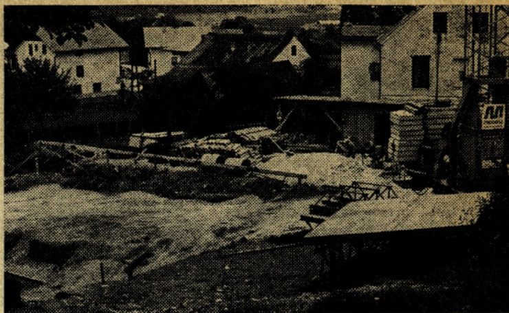
Gradbišče trgovine »M. Jelša« v Bistrici ob Sotli
