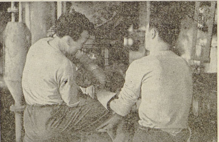
Privijanje vijakov z natezalnim avtomatskim ključem Iz strojne delavnice — Foto Stojan Kerbler
