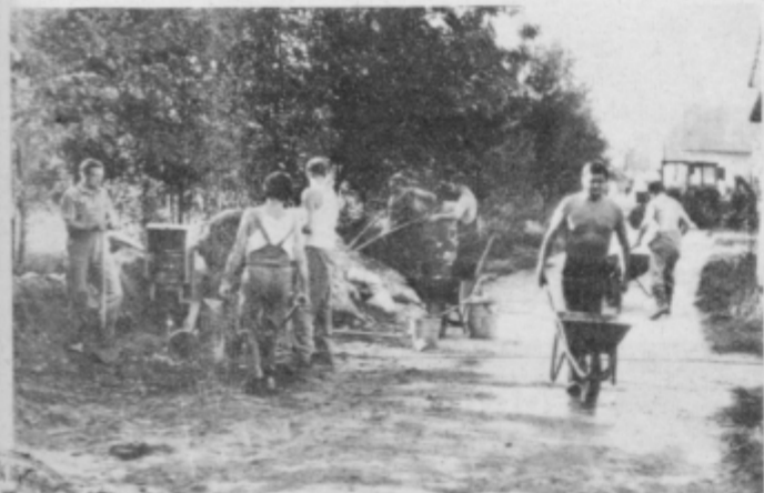
Ljubljanci so bili pridni delavci pri mešanju betona.
