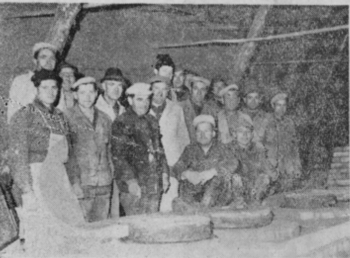
Zidarji Građenj pri gradnji nove peči za Opekarno Zabjak
