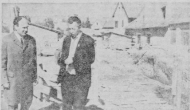
Kari Vobner, direktor TP Merkur, in Mirko Korošec, KB Ptuj, med ogledom gradnje avtosalona in nove poslovno stanovanjske stavbe.
