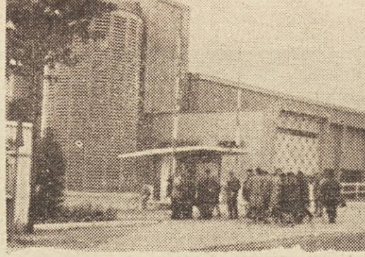
Vhod v obrat Coigneta — levo silos za gramoz
