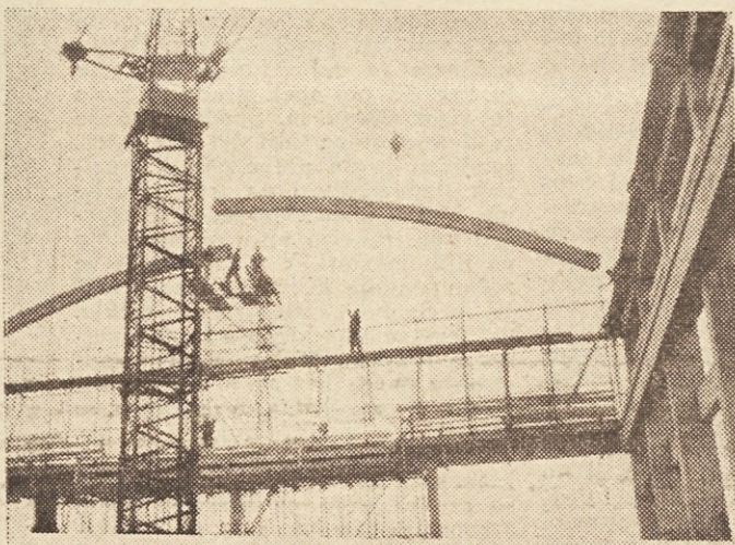
Slika 1: Montaža ločenih nosilcev na gradbišču PE Ljubljana-okolica. Prva faza dviganja nosilca iz deponije ■ Slika 2: Tovariš Bučan čaka na nosilec ■ Slika 3: Pol loka je na svojem mestu ■ Slika 4: Montaža druge polovice loka ■ Slika 5: Obe polovici loka pri stiku ■ Slika 6: Oddelek priprave dela na centrali podjetja: inž. Erjavec, inž. Prihoda, Pergar, inž. Marija Dolenc, inž. Znidaršič po fotografira ■ Projekt organizacije gradbišča in montaže je bil izdelan v oddelku priprave dela operativne službe centrale
