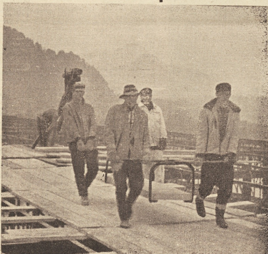
Zgoraj: Delavci raznašajo krovne strešne plošče v višini ca. 19 m po delovnem podu brez ograje. Izpostavljeni so nevarnosti, da padejo. Posledica je lahko samo smrt. Tako delo je v nasprotju z vsemi varnostnimi predpisi, prav posebno pa z določili 22. člena našega pravilnika o službi higiensko tehničnega varstva v podjetju Gradis
