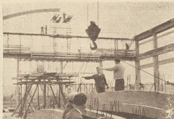
Slika 1: Montaža ločenih nosilcev na gradbišču PE Ljubljana-okolica. Prva faza dviganja nosilca iz deponije ■ Slika 2: Tovariš Bučan čaka na nosilec ■ Slika 3: Pol loka je na svojem mestu ■ Slika 4: Montaža druge polovice loka ■ Slika 5: Obe polovici loka pri stiku ■ Slika 6: Oddelek priprave dela na centrali podjetja: inž. Erjavec, inž. Prihoda, Pergar, inž. Marija Dolenc, inž. Znidaršič po fotografira ■ Projekt organizacije gradbišča in montaže je bil izdelan v oddelku priprave dela operativne službe centrale
