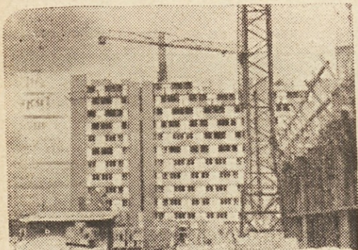
Gradbišče montažnega stanovanjskega bloka sistema Camus
