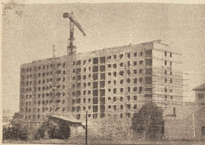
Zerjav »Weitz« je končal svoje delo na bloku B-1 v Siški ter nestrpno pričakuje premestitve na enak blok B-2, ki je oddaljen samo 200 metrov. Ko bosta oba bloka gotova, bo na razpolago skupaj 276 stanovanj. Investitor je stanovanjski sklad ObLO Ljubljana-Siška
