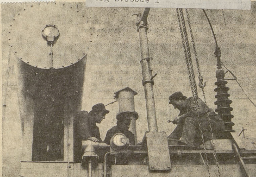
Popravilo transformatorja
